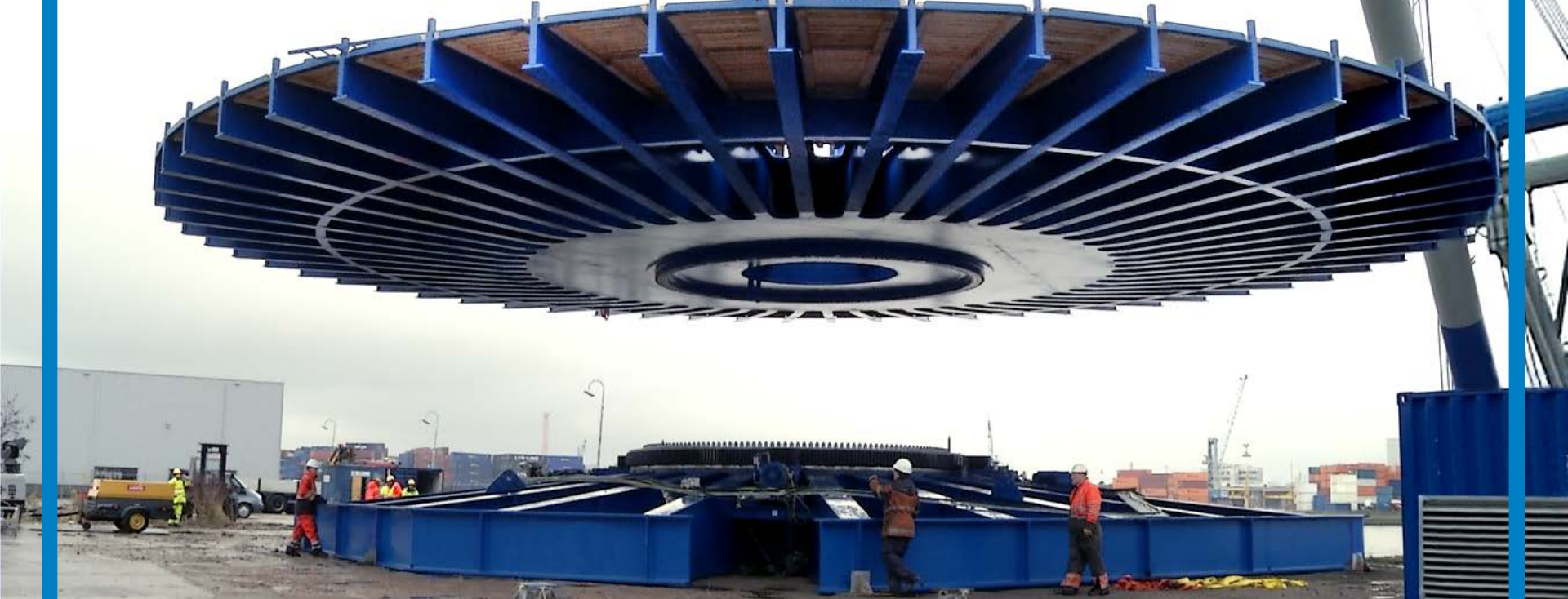
Installation af drejeskive på logistikcentret i Rotterdam
